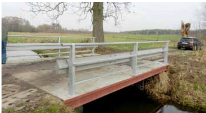
Tak jest po remoncie
