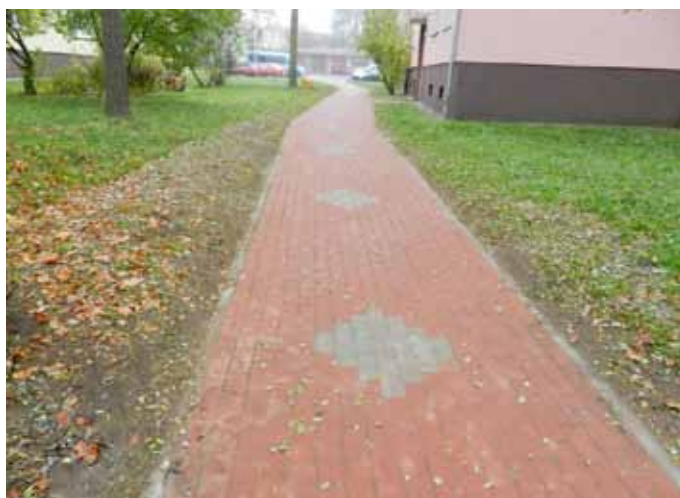
Tak jest po remoncie
