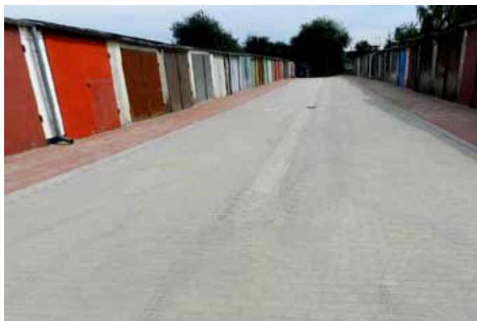
Tak jest po remoncie
