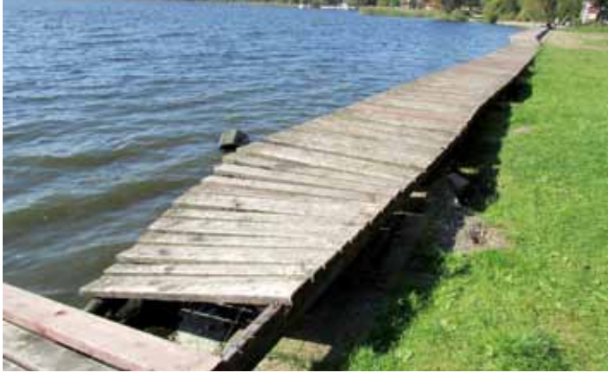
Stan przed remontem
