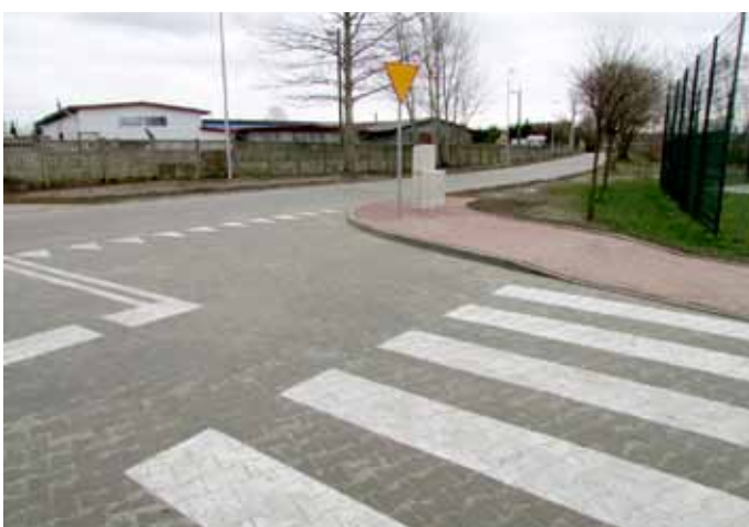
Tak jest po remoncie
