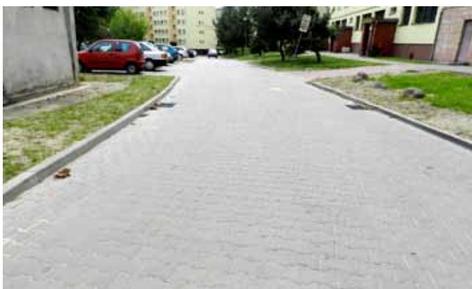
Tak jest po remoncie
