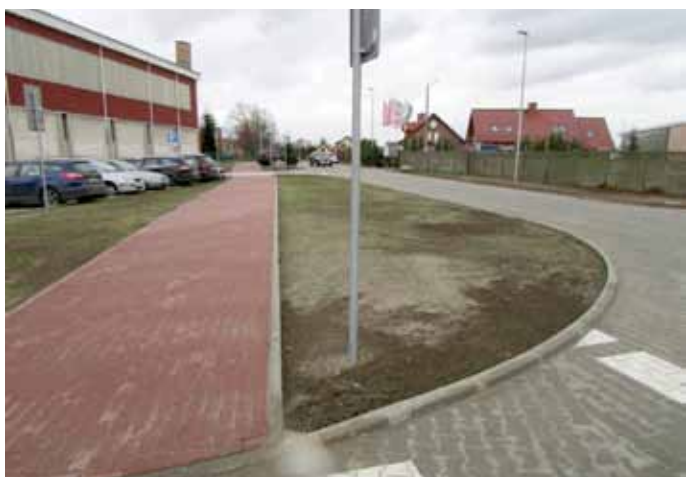
Tak jest po remoncie
