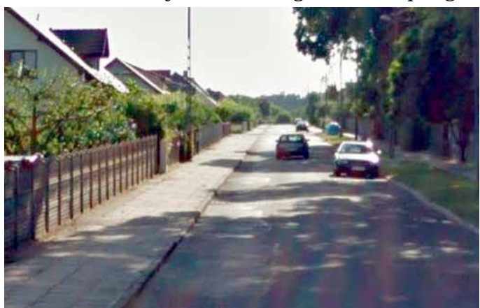
Tak było przed remontem
