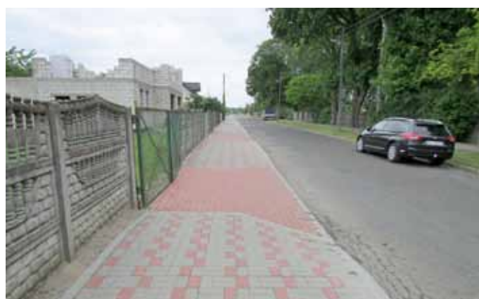
Tak jest po remoncie
