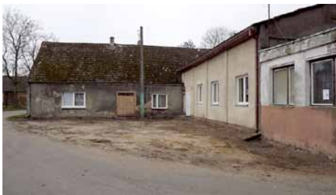
Tak było przed remontem
