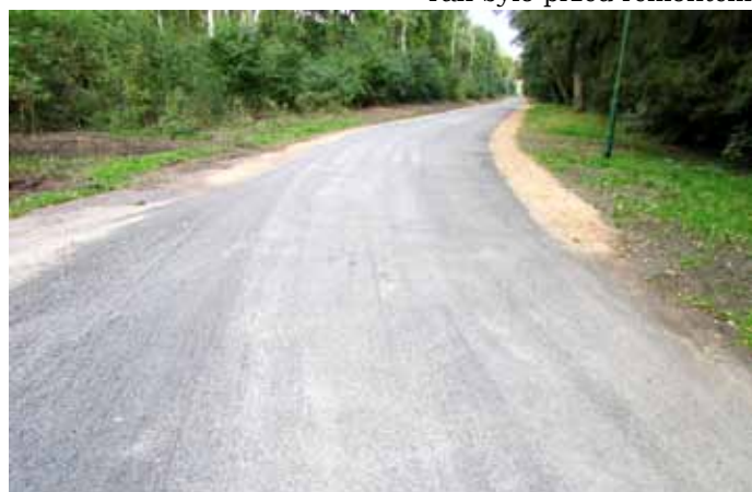
Tak jest po remoncie
