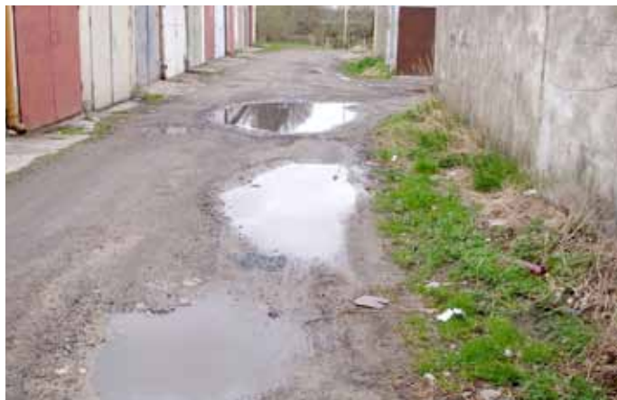
Tak było przed remontem
