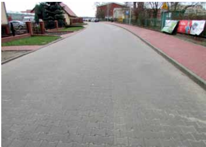
Tak jest po remoncie
