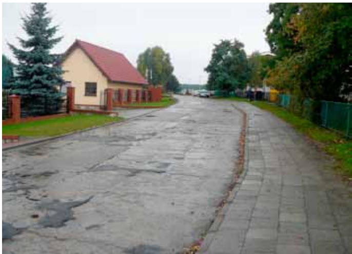
Tak było przed remontem
