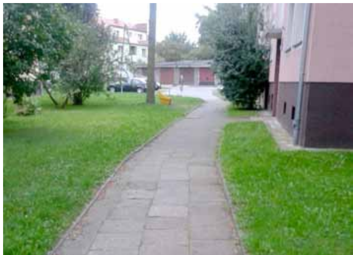
Tak było przed remontem
