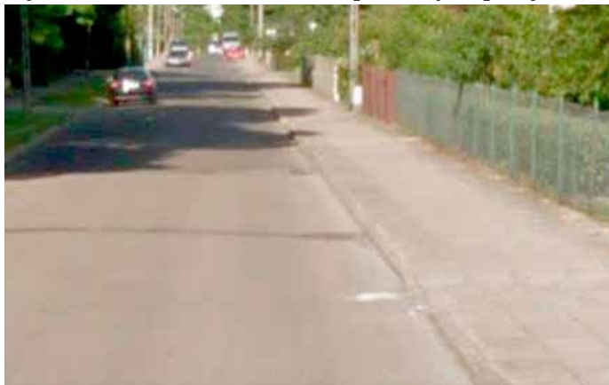
Tak było przed remontem
