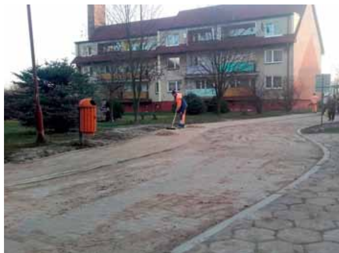
Tak jest po remoncie
