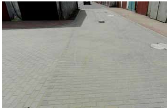
Tak jest po remoncie
