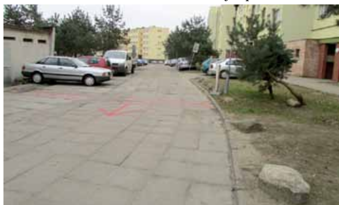
Tak było przed remontem
