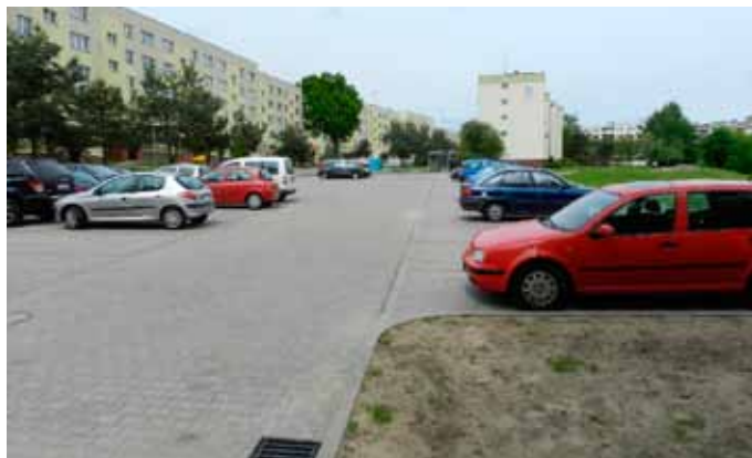
Tak jest po remoncie
