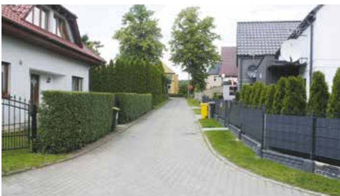
Kolejna „ciemna” ulica będzie oświetlona
